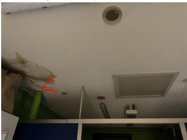
039 : Enduit projeté avec bande joint Sanitaires 2 (niv:0) - PRE:FRG017
