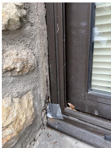
042 : Mastic assemblage menuiserie aluminium Dégagement (niv:0) - PRE:FRG019
