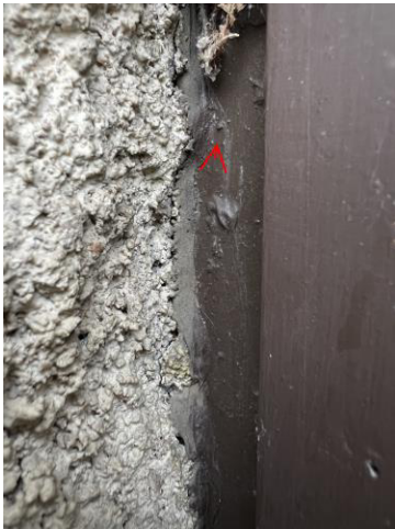
008 : Mastic assemblage menuiserie/maçonnerie Façades (niv:Ext) - PRE:FRG005
