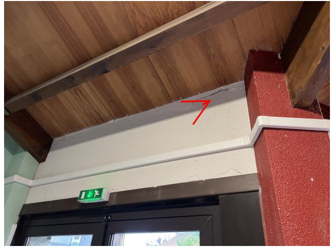
002 : Enduit projeté Hall (niv:0) - PRE:FRG002
