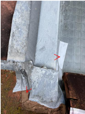
014 : Mastic verrière Dégagement (niv:0) - PRE:FRG009
