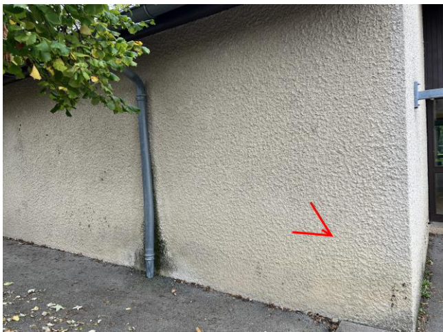
020 : Enduit extérieur Façades (niv:Ext) - PRE:FRG014
